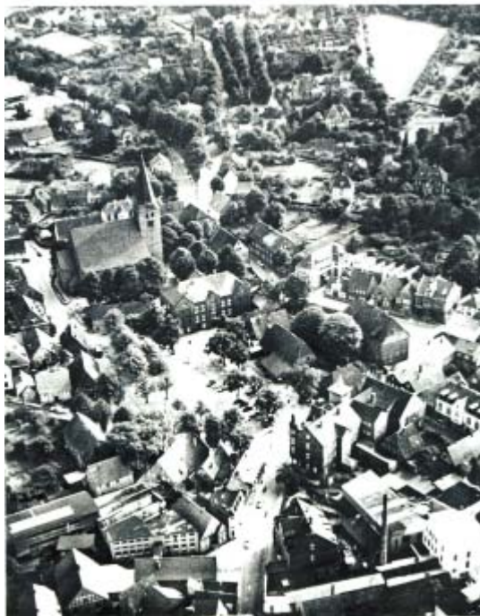
Luftbild vor der Sanierung
