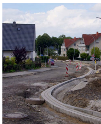
Der mittlere Bauabschnitt der Bergstraße.
