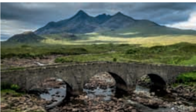
Alte Brücke von Sligachan.
