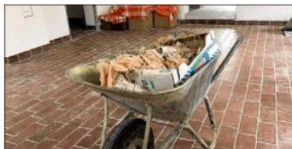
In dem künftigen Versammlungsraum erinnert nur noch der rote Steinfußboden an das ehemalige Spritzenhaus.
