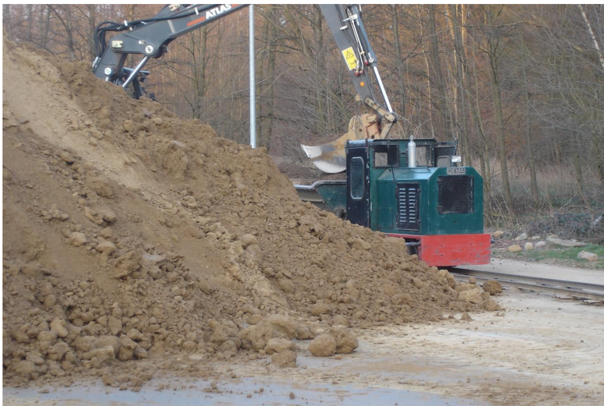
Abbildung 5: Beladung der Kleinbahn im südlichen Plangebiet (03.04.2022)
