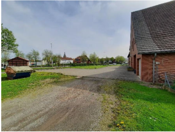
Foto 3: Versiegelung an der Hofstelle
