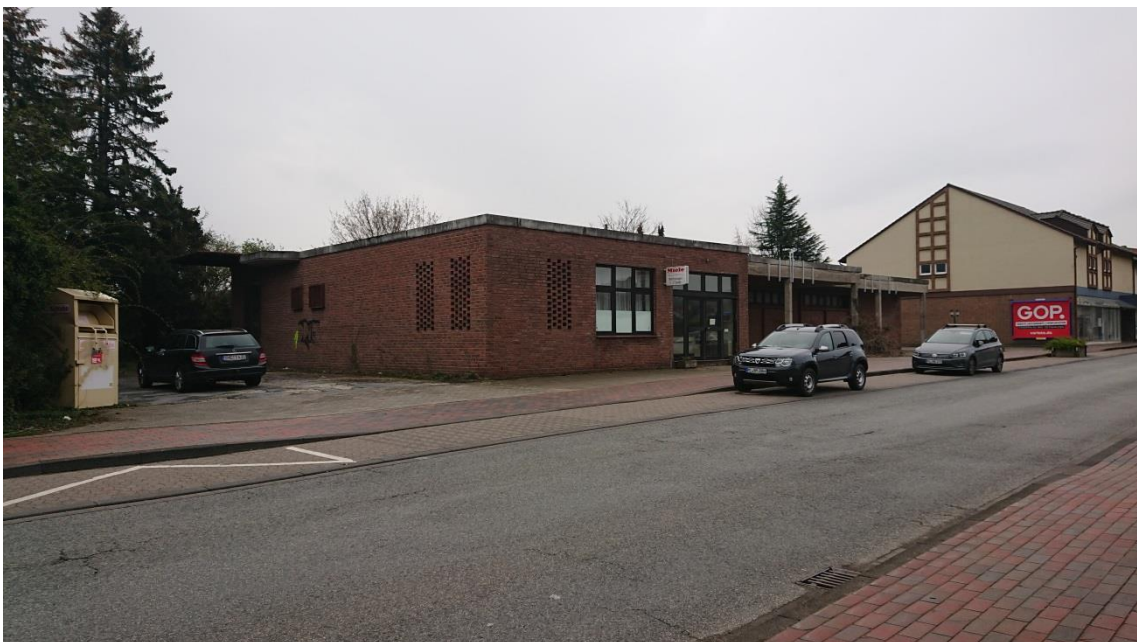
Abbildung 3: Abzubrechender Gebäudekomplex entlang der Bremer Straße, Blickrichtung Süden
