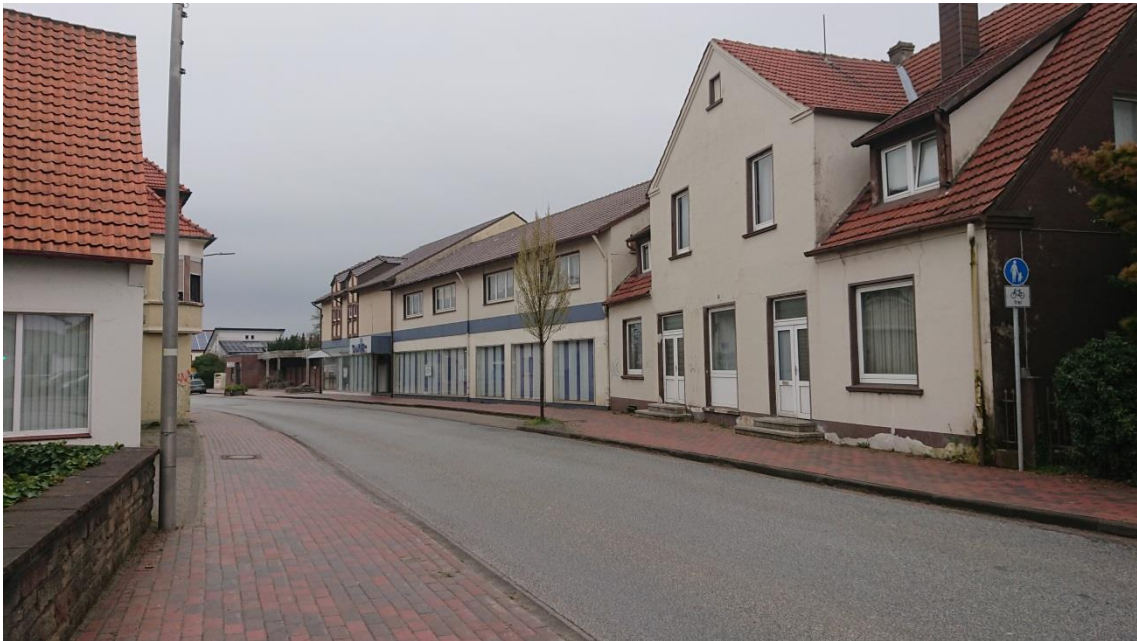
Abbildung 2: Abzubrechender Gebäudekomplex entlang der Bremer Straße, Blickrichtung Norden
