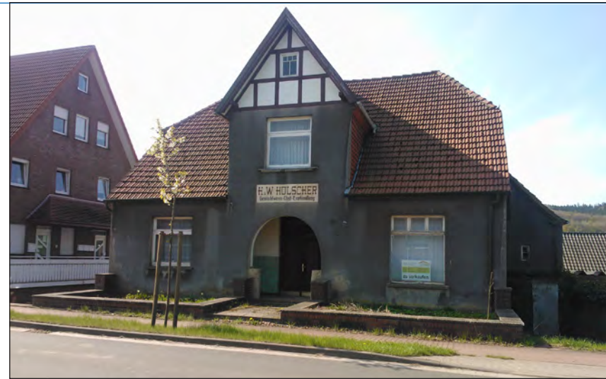
Abb. 34: Putzbau mit Zwerchhaus 1 und Krüppelwalm, ehemalige Gemischtwarenhandlung an der Eggetaler Str. in Börninghausen Masch, Foto: H. Jung
