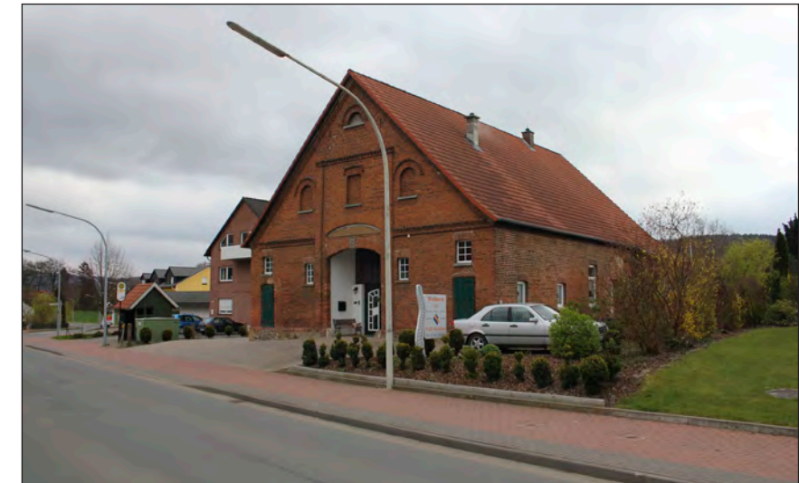
Abb. 31: Haus Eggetaler Straße 42, heute Massagepraxis, als Beispiel für den Wandel in der Bauweise, Foto: H. Lüdeling
