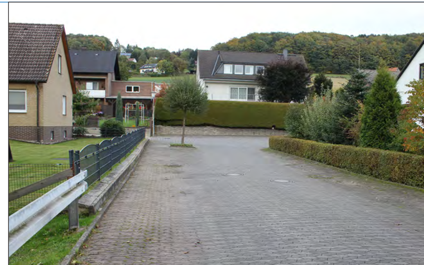
Abb. 40: Siedlung „An der Hauwiese“ im Stil der späten 60er / 70er Jahre, überbreit wirkender, ungliederter Straßenraum, eine teilweise Entsiegelung würde nicht nur Unterhaltungskosten sparen, sondern auch den ökologischen Nutzen erhöhen, Foto: H. Lüdeling
