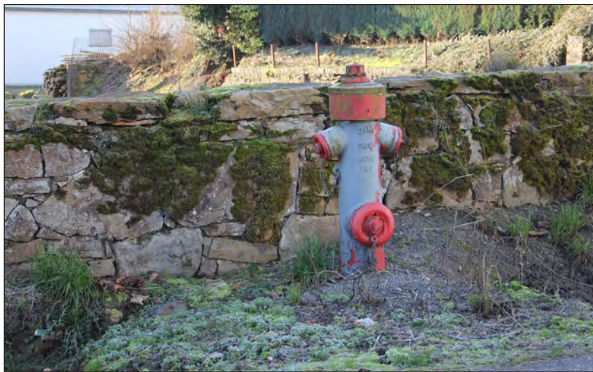
Abb. 57: Historische Natursteinmauer in Eininghausen mit Hydrant der Löschwasserversorgung, Foto: H. Lüdeling
