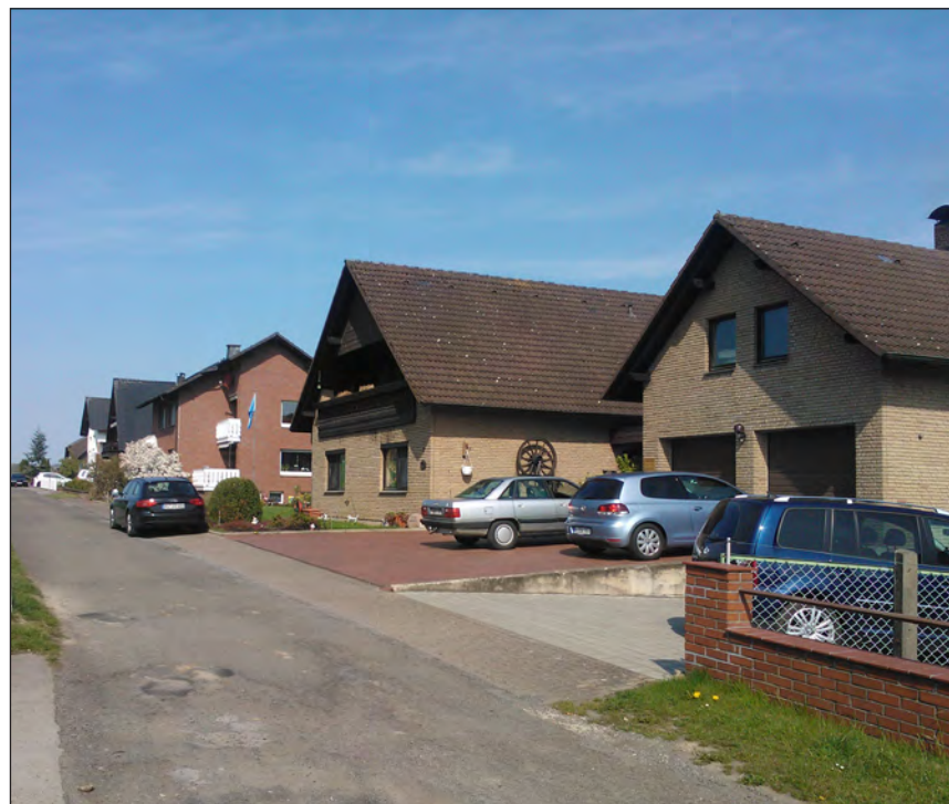
Abb. 39: Siedlungshäuser im Stil der 70er und 80er Jahre am Sickenweg. der Materialmix deutet auf eine starke Individualisierung hin, eingezogene Loggien sind energetisch ungünstig, die Mobilität und nicht das Wohnen wird in den Vordergrund gesetzt, Foto: H. Jung
