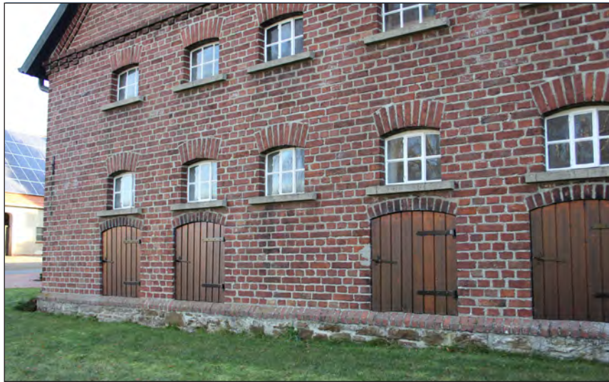
Abb. 32: Restauriertes Wirtschaftsgebäude in Ziegelbauweise „An der Kirche 15“, Ecke Eickwiesenstraße, Foto: H. Lüdeling
