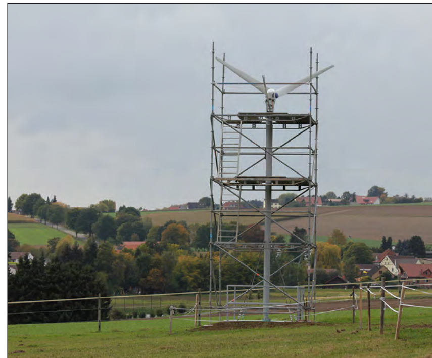
Abb. 20: Installation der Kleinwindkraftanlage an der Eimsiekstraße, Foto: H. Lüdeling
