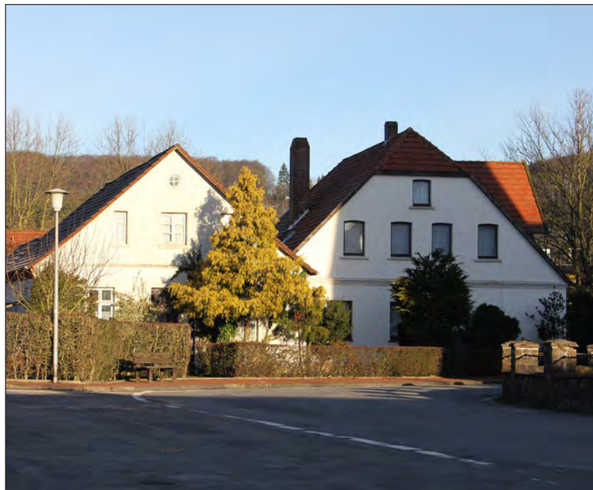
Abb. 68: Schützenswertes Gebäudeensemble an der Ulricuskirche, Foto: H. Lüdeling
