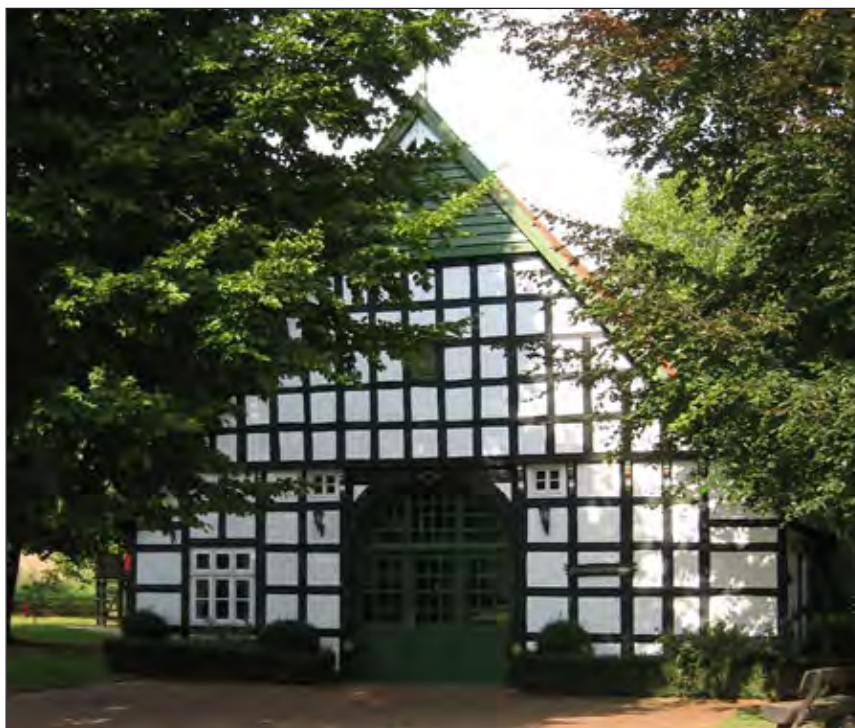
Abb. 33: Haus der Begegnung, ein aus Eininghausen translozierter Zweiständerfachwerkbau, Foto: H. Jung
