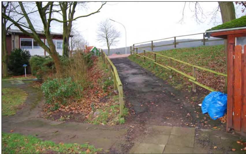
Abb. 111: Zugang zum Haus der Begegnung mit zu starkem Gefälle, Foto: H. Verhaagen
