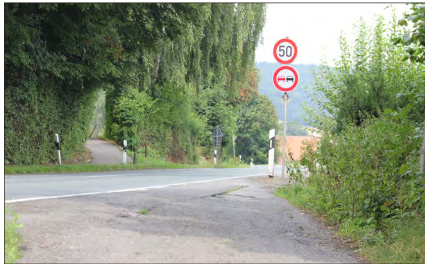
Abb. 108: Situation an der Radwegquerung Bündler Straße / Neue Mühler Weg. Deutlich ist das ungünstige Quergefälle und die fehlende Aufstellfläche zu erkennen.: H. Lüdeling
