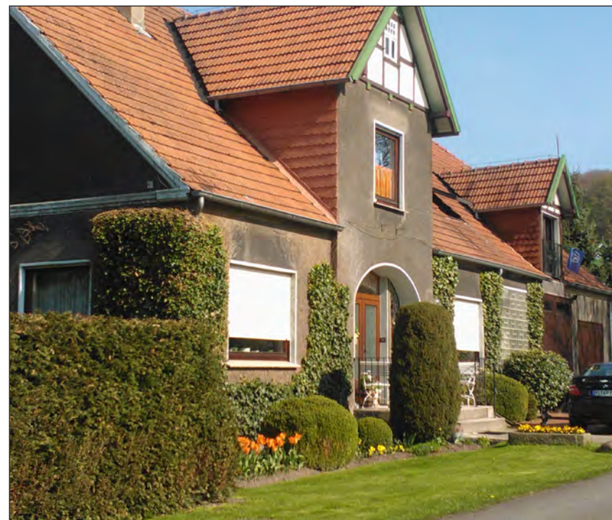
Abb. 35: Putzbau mit Zwerchhaus 1 , Wittekindsstr. 4, baugleich wie Abb. 34, Foto: H. Jung
