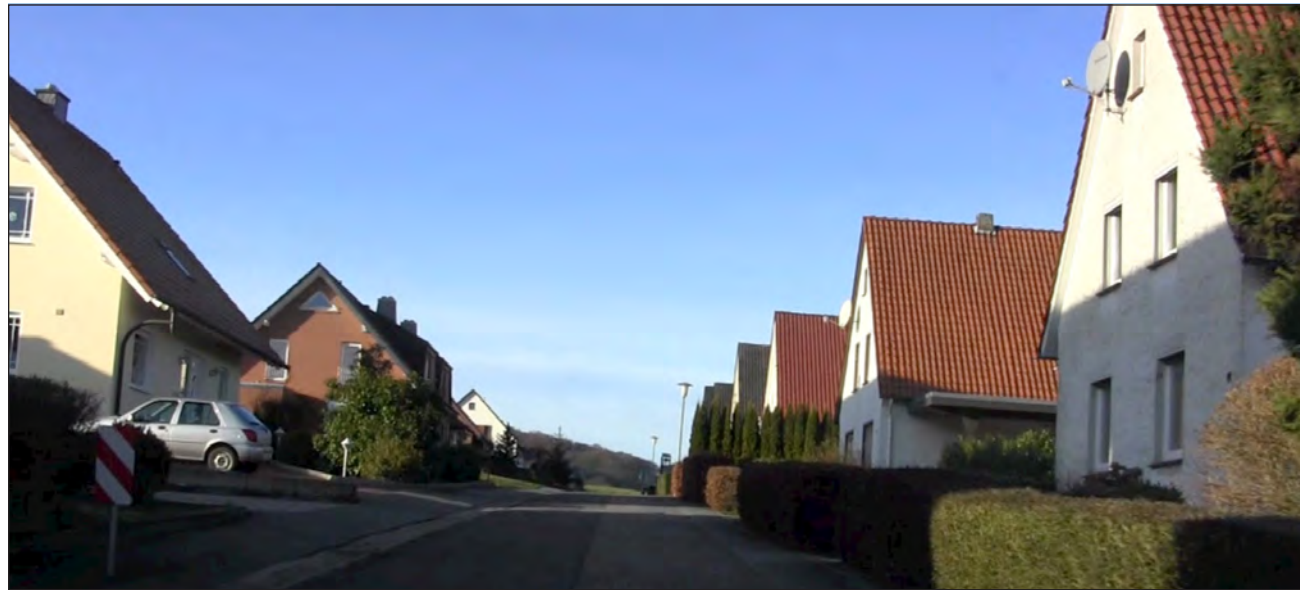
Abb. 70: Gebäude an der Heulandstraße, in absehbarer Zeit energetisch zu sanieren, Foto: H. Lüdeling
