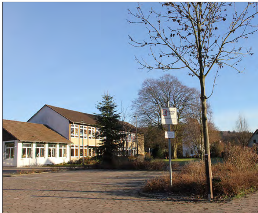
Abb. 23: Grundschulstandort Börninghausen von der Feuerwehr aus gesehen, Foto: H. Lüdeling
