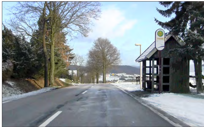
Abb. 110: Bushaltestelle an der Eggetaler Straße, Foto: H. Lüdeling
