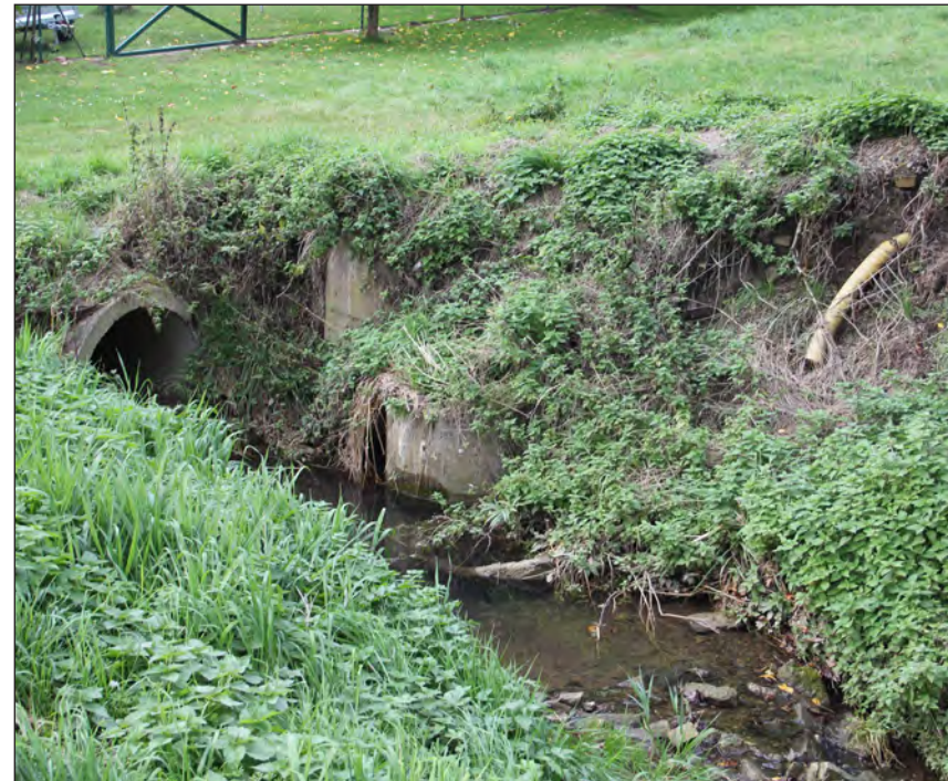
Abb. 09: Rohrdurchlass und Ufer-Abbruch am Mühlenbach (Ravensberger Straße), Foto: H. Lüdeling
