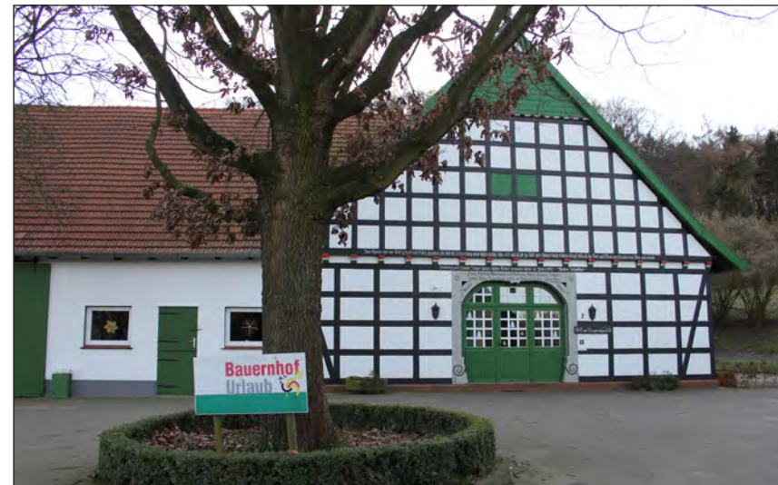
Abb. 30: Hof Stapel, zur Egge 2, heute. Ein Beispiel dafür, wie ein nicht maßstäblich gehaltener Anbau die alte Würde des Gebäudes verletzen kann. Der früher imposant wirkende Vierständerbau wirkt wie geschrumpft, Foto: H. Lüdeling
