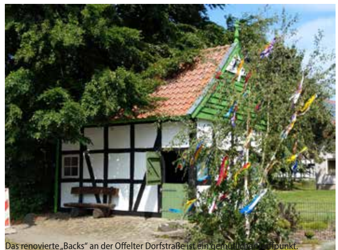
Das renovierte „Backs“ an der Offelter Dorfstraße ist ein gemütlicher Treffpunkt.
