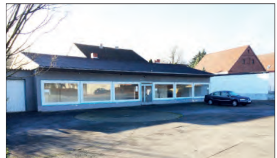
Mängel an Gebäuden in Bereichen mit stärkerem Leerstand in Preußisch Oldendorf (oben) und Bad Holzhausen (unten)
