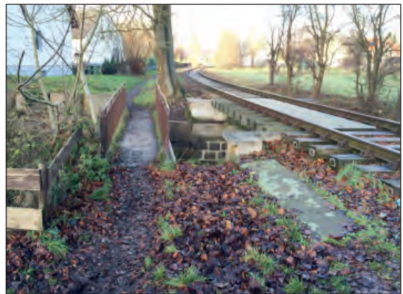
Schlechter, unsicherer Weg zu den Märkten an der Bundesstraße mit Querung der Großen Aue (Teilbereich 8.1).
