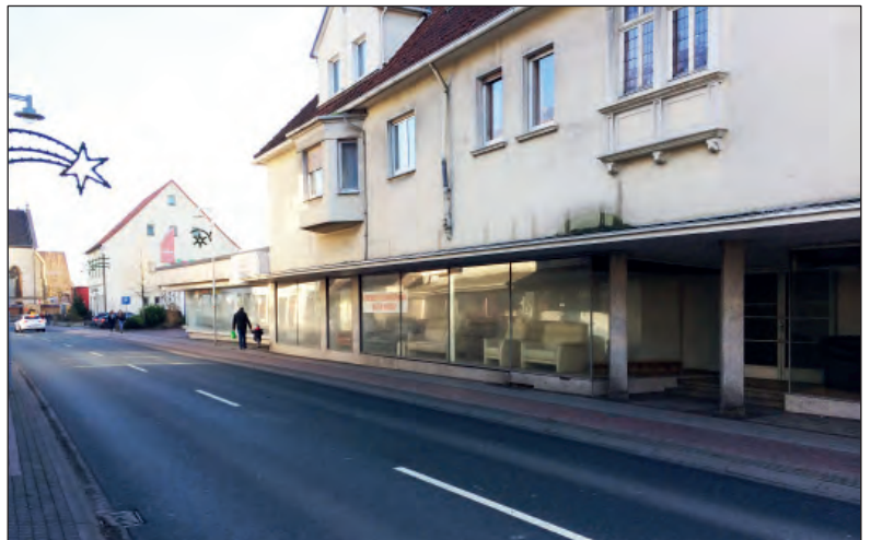
Leerstand Gebäude an der Ortsdurchfahrt der B 65 - Spiegelstraße
