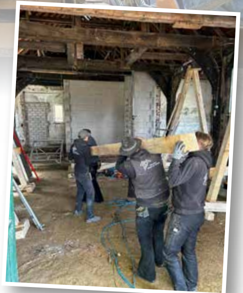
Die Entkernung ist geschafft, nun beginnt die Fachwerksanierung durch die Zimmerei Moritz von Spiegel.
