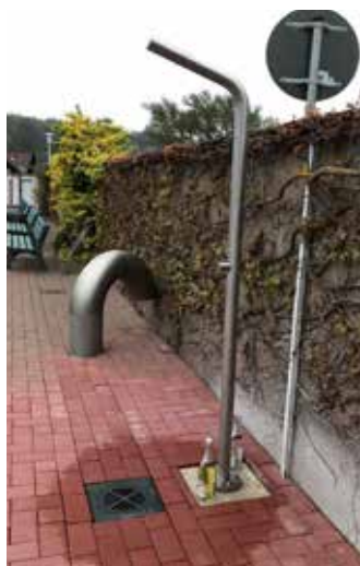
Die neue Außendusche.
