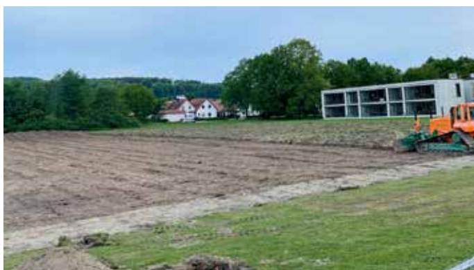
Die Firma Heiler beginnt mit den Erdarbeiten.
