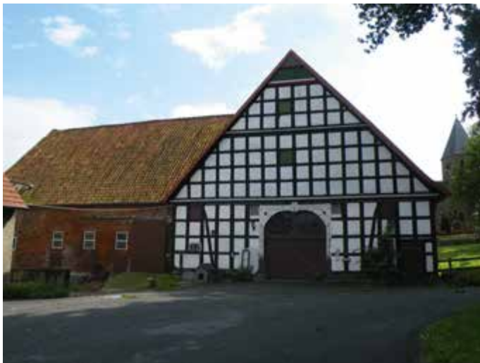
Hof Overmeyer an der B65 in Bad Holzhausen
