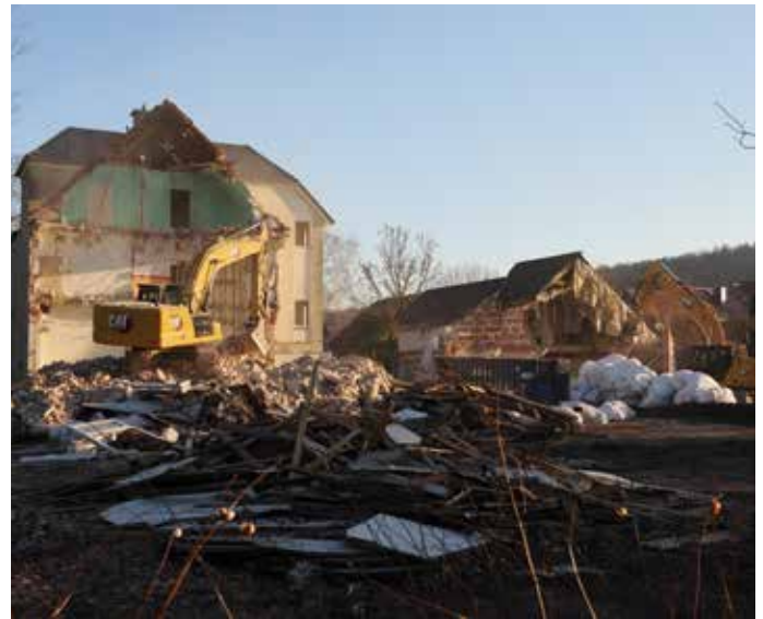
Abrissarbeiten im Januar 2024. Mit der Innenentkernung und dem Abbau der Außentreppe hatte man bereits im Herbst letzten Jahres begonnen.
