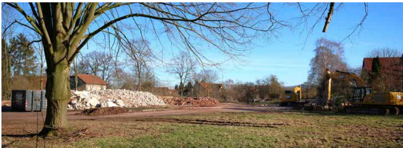
Auf dem ehemaligen Gelände des Pollertshof soll unter anderem eine neue Kindertagesstätte entstehen.
