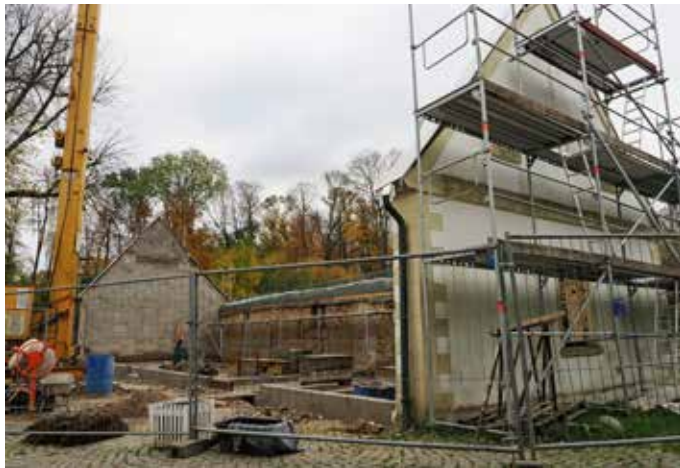
Die Baustelle im Kurpark.
