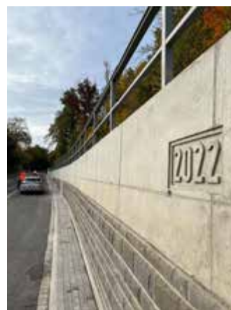
Die neue 2,3 Meter hohe und 136 Meter lange Stützmauer.
