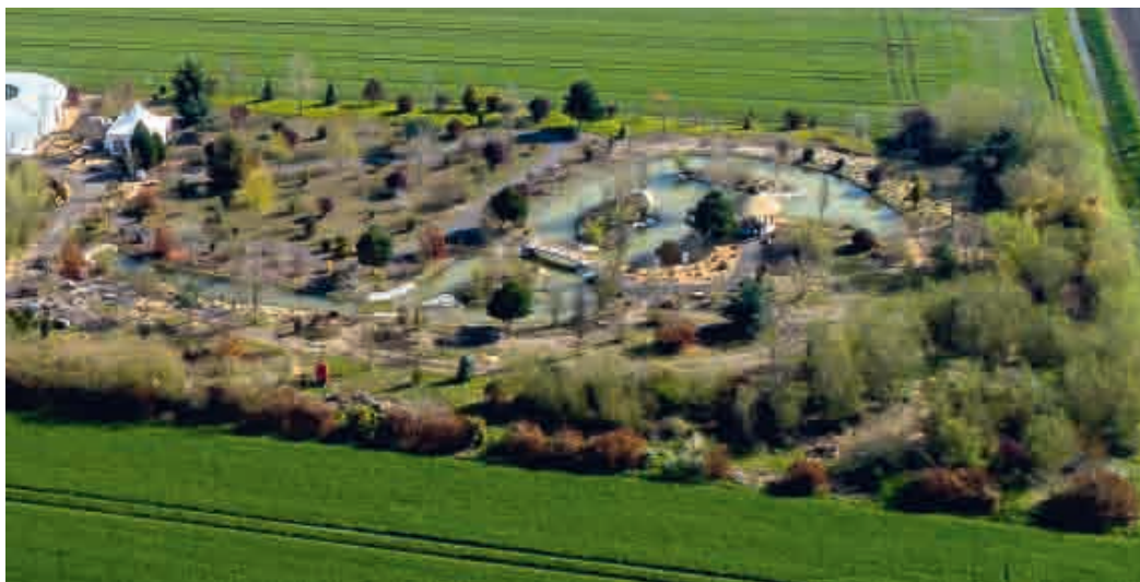
Ein Blick auf die neue Parklandschaft mit Wasserfläche, Brücke und Pavillon.
