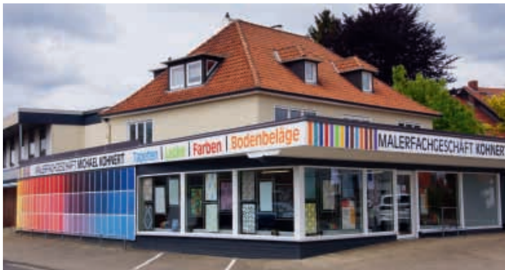
Eine bunte Farbpalette an der aufgefrischten Fassade des alten Horstmann-Gebäudes an der B65 Ecke Am Alten Markt.
