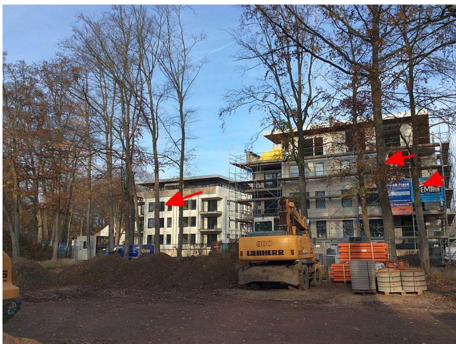
Abbildung 1: Buchenreihe im aktuellen Baustellenbereich, deutlich erkennbar sind einige Astlöcher mit Initialhöhlen.
