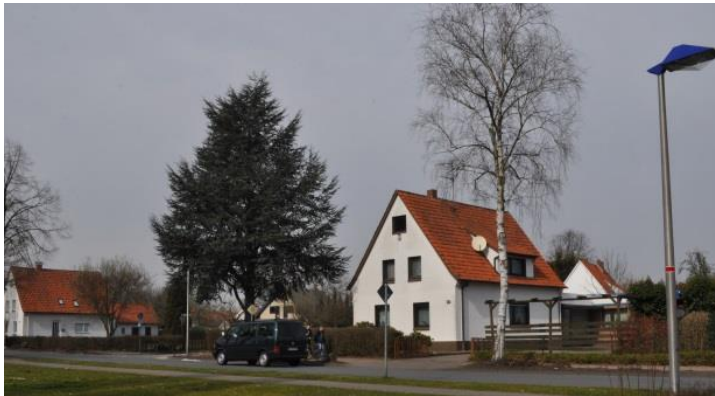
Abbildung 28: Blick in die Heinrich-Drake-Siedlung
