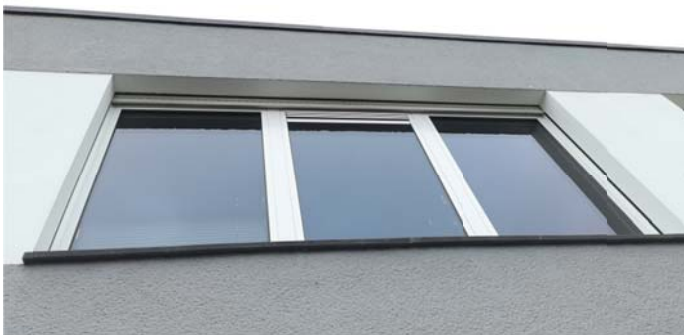
Nr. 16 Bereich hinter Außenschalousie mittlere Wertigkeit: diese Nische wird gelegentlich von Fledermäusen genutzt, aber nicht bei häufiger Bewegung, gute Isolierung
