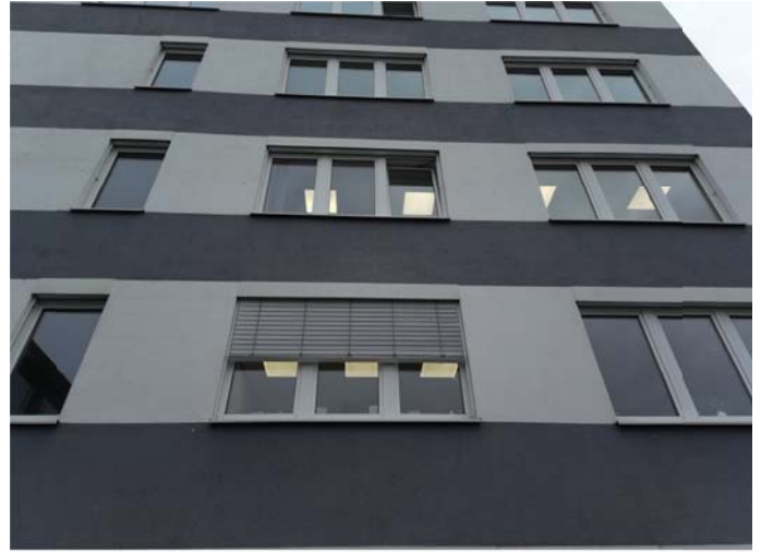
Nr. 11 Bereich hinter Außenschalousie mittlere Wertigkeit: diese Nische wird gelegentlich von Fledermäusen genutzt, aber nicht bei häufiger Bewegung, gute Isolierung
