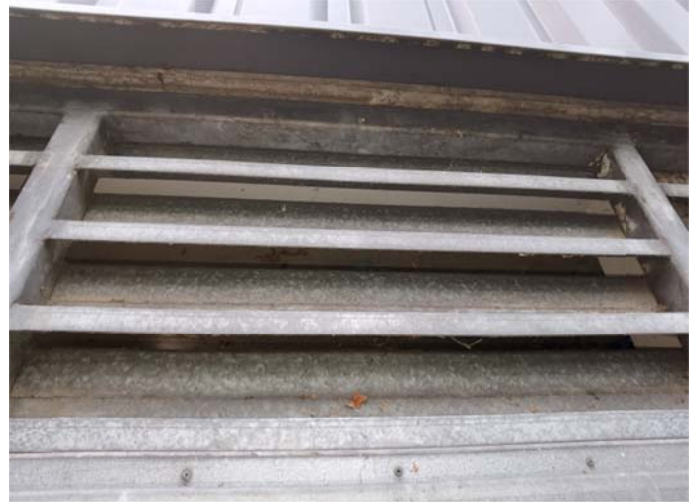
Nr. 33 Lüftungsschlitze der Tiefgarage als Quartier nicht geeignet, gewährleistet aber den Zugang zur Tiefgarage
