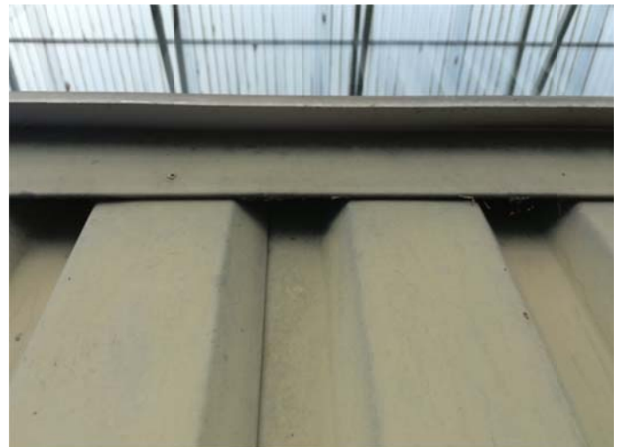
Nr. 6 Mögliches Tagesquartier hinter Dachverkleidung keine Wertigkeit: keine Halbmöglichkeit, Auskühlung durch Metall
