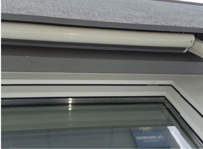
Nr. 21 Bereich hinter Außenschalousie an Neubau ohne Wertigkeit: durch Absperrgitter ist ein Einflug nicht möglich
