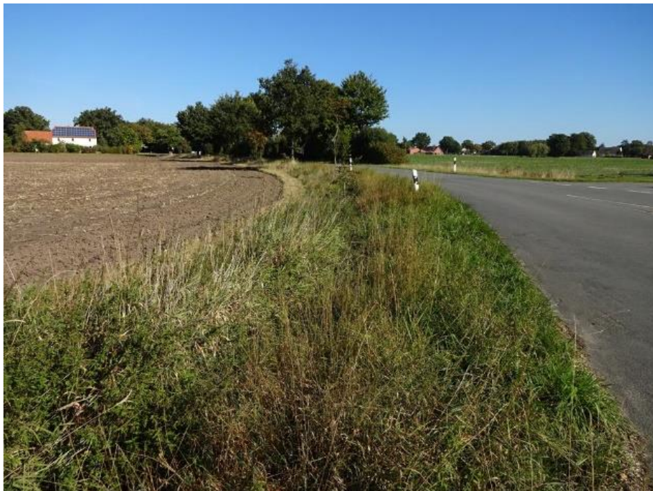
Abbildung 8: Bankette entlang der Heuerhofstraße, Blickrichtung Norden
