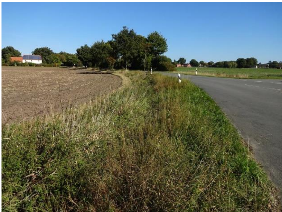
Abbildung 8: Bankette entlang der Heuerhofstraße, Blickrichtung Norden
