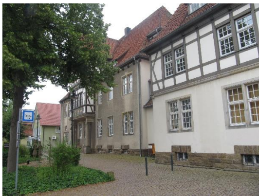
Abbildung 39: Fehlende Aufenthaltsqualität am „Alten Amtsgericht“
