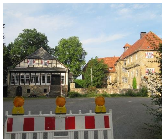
Abbildung 22: Ist-Situation, Kein Zugang
