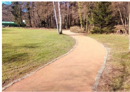
Abbildung 34: Beispiel einer wassergebundenen Wegedecke
