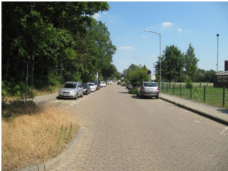
Abbildung 22: Temporäre Sperrung des Bultwegs
