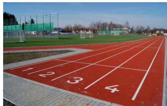
Abbildung 14: Beispiele für die Ertüchtigung der Außensportanlage
