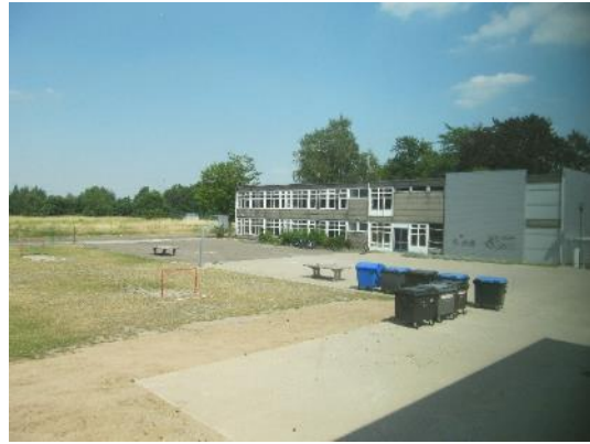
Abbildung 60: Stark versiegelter Innenhof
