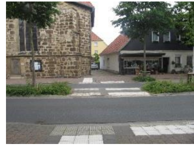
Abbildung 29: Barrierearme Querungsstelle an Hauptstraße auf Höhe Petrikirche
