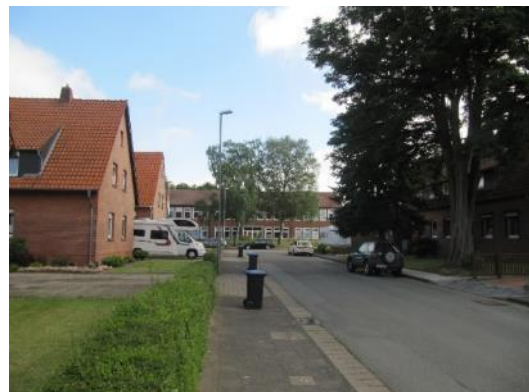
Abbildung 78: Blick auf das Grundschulgebäude
