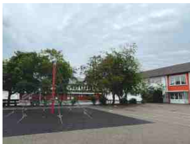
Grundschule in Oppenwehe
