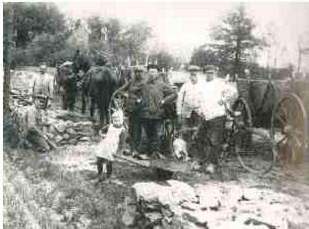
Straßenbau im Hand- und Spanndienst, Twiehausen, 1928
