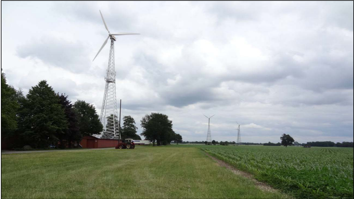
Abbildung 1: Blick auf das Plangebiet / die Konzentrationszone mit Standorten bestehender WEA
