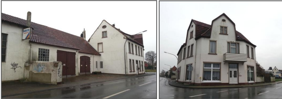
Abb. 88: Ansicht Prüfstandort Lübbecke Straße/ Mindener Straße
