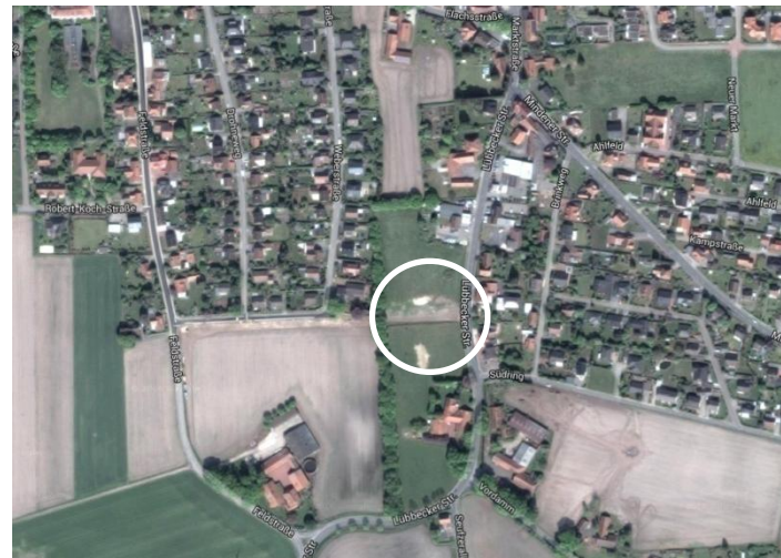
Abb. 81: Luftbild Prüfstandort Lübbecke Straße
