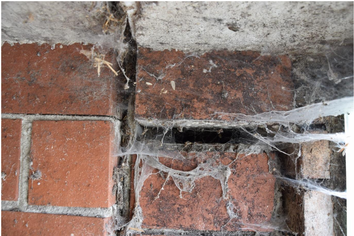
Abb. 4: potenzielles Spaltenquartier; südlicher Anbau (ehem. Stall)
