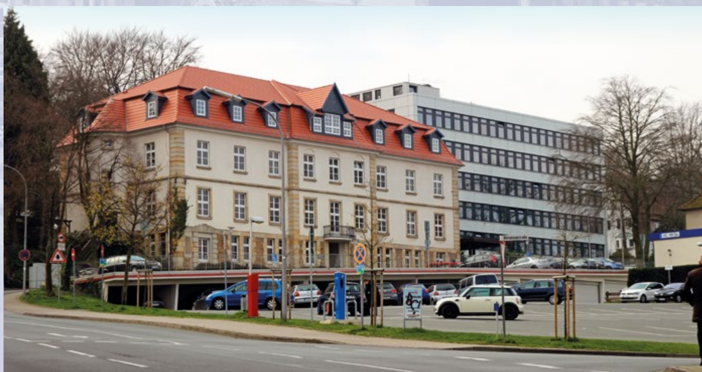
Stadtverwaltung mit Parkplatz Weingarten
