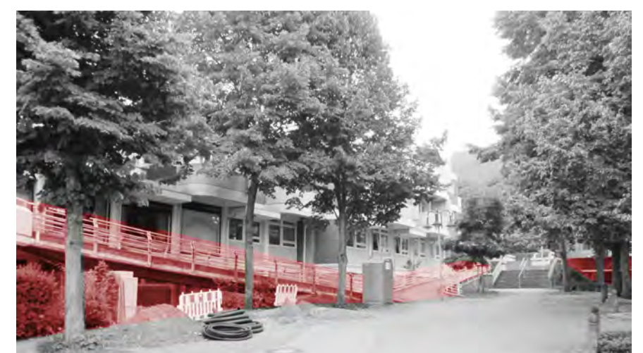
Rampen und Treppen zum Kirchplatz
