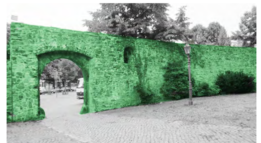
historische Mauer mit Torbogen
