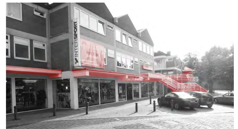
Marktplatz: zahlreiche Vorbauten am Gebäude
