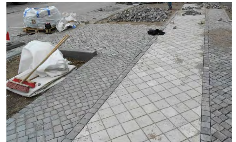
Taktile Kontrast: Gehbahn = ebenflächig Unter-/Oberstreifen = rau
