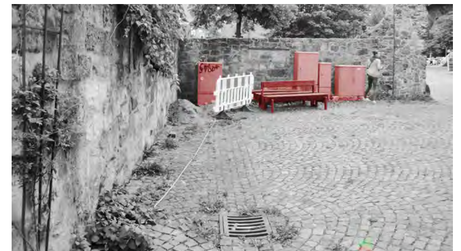
Stromkästen beeinträchtigen das Erscheinungsbild
