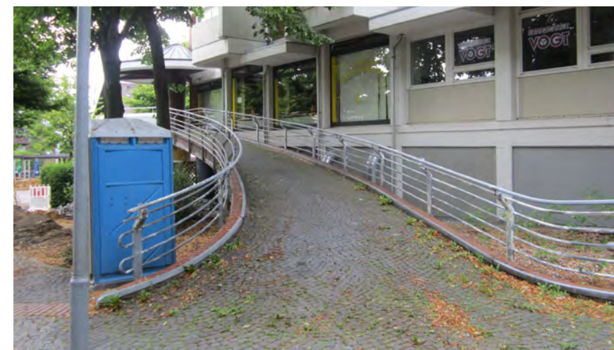
Rampe vom Marktplatz zur +1 Ebene
