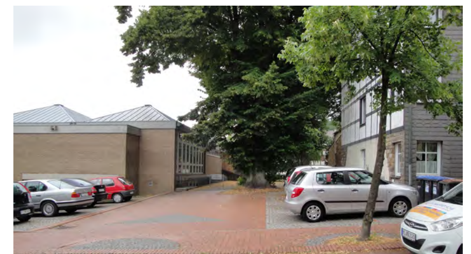
Barrierefreier Zugang Kirchplatz
