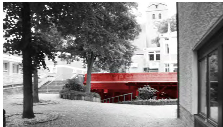
Schwäche: übergang Tiefgarage
