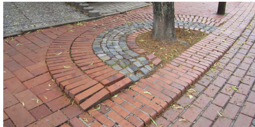
Stolperkanten durch Verwerfungen
