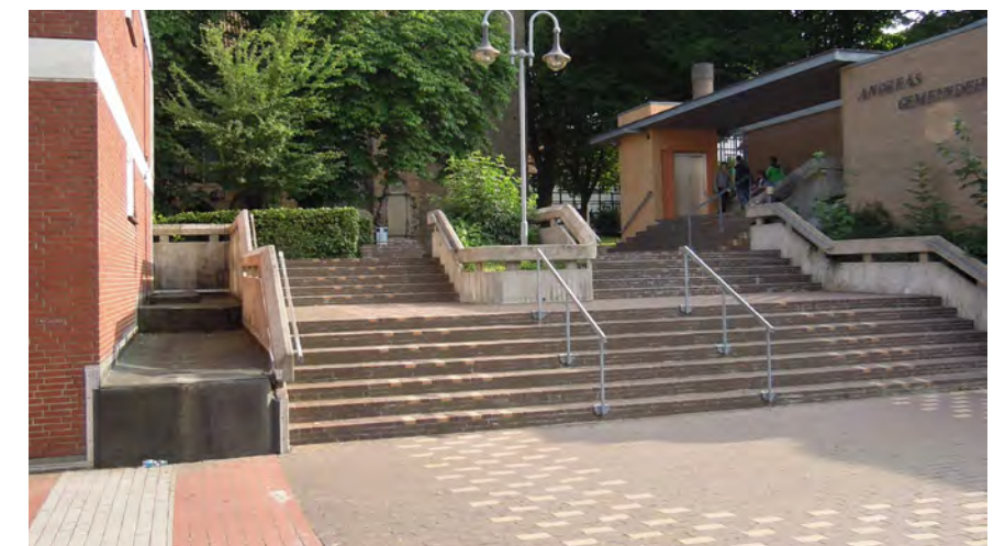
Treppenanlage zum Kirchplatz von der +1 Ebene
