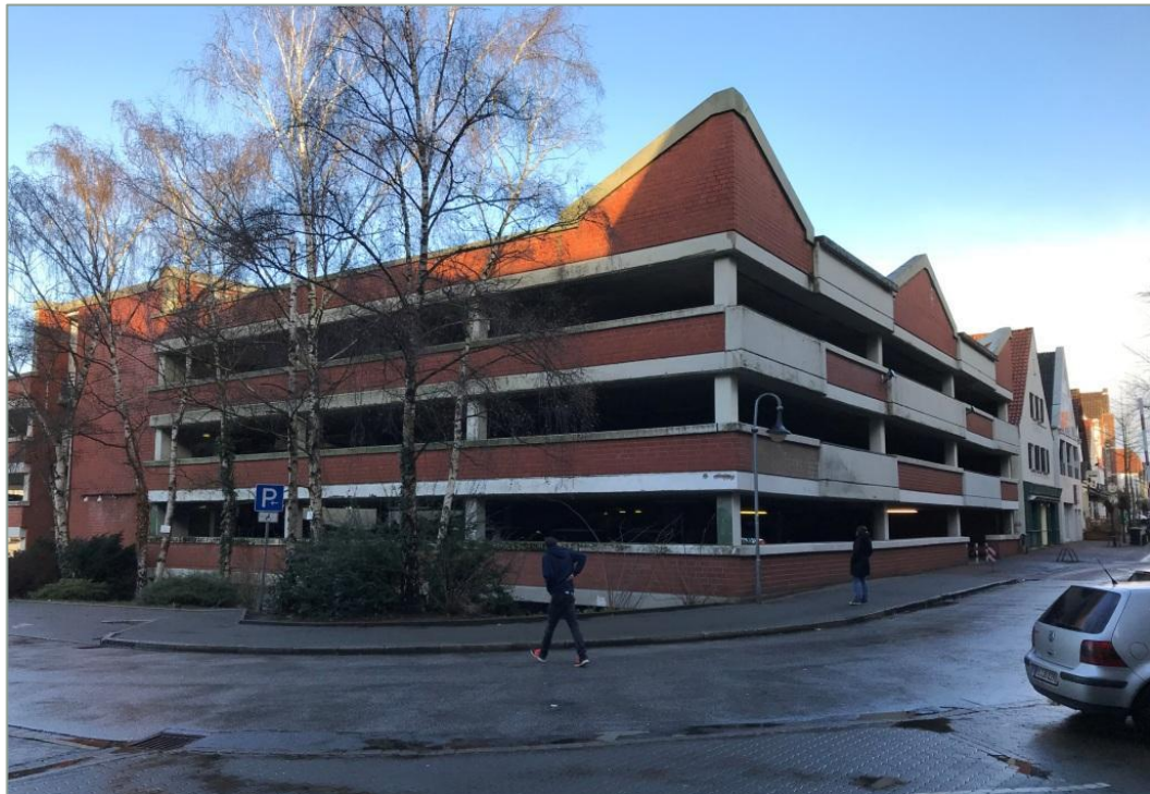
Abbildung 4: Parkhaus West an der Niedernstraße
