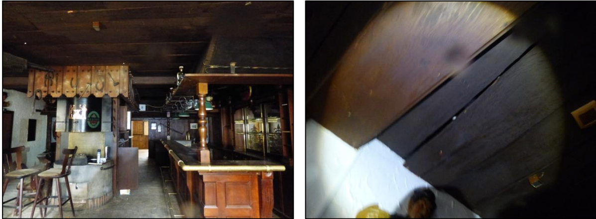
Abbildung 13: Gaststätte im Erdgeschoss mit Spalten in der Holzvertäfelung
