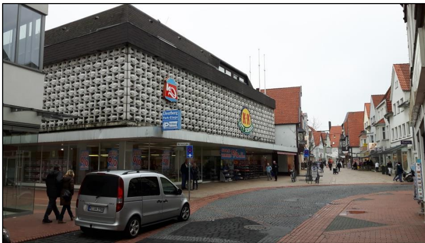
Abbildung 3: Blick auf den östlichen Gebäudeteil des Deerberg-Kaufhauses (links im Bild) von der Lange Straße
