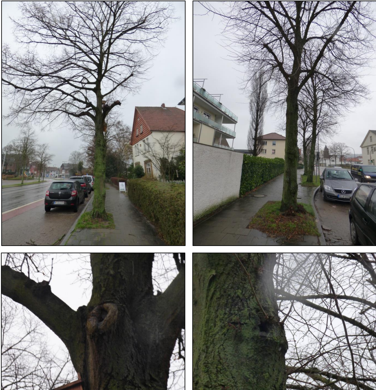
Abbildung 17: Baumreihe nördlich der Straße Niederwall, teilweise mit Hohlräumen
