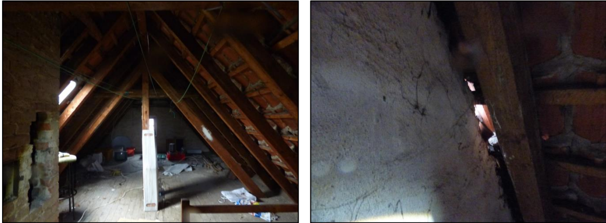
Abbildung 15: Dachboden mit potenziellen Einflugmöglichkeiten
