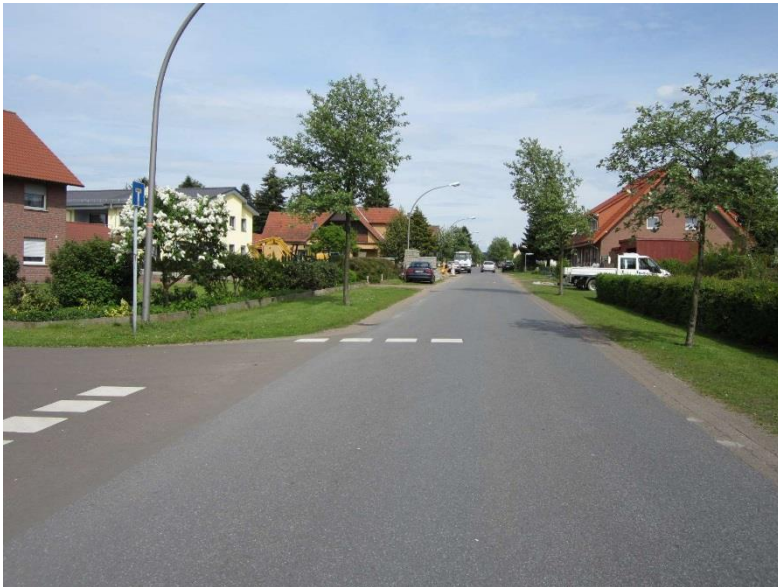
Bauerbrinker Straße (Straßenabschnitt 4509-01)
